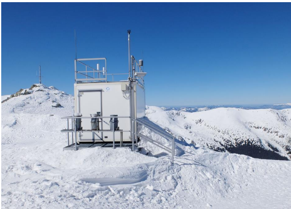
Pohľad na stanicu
