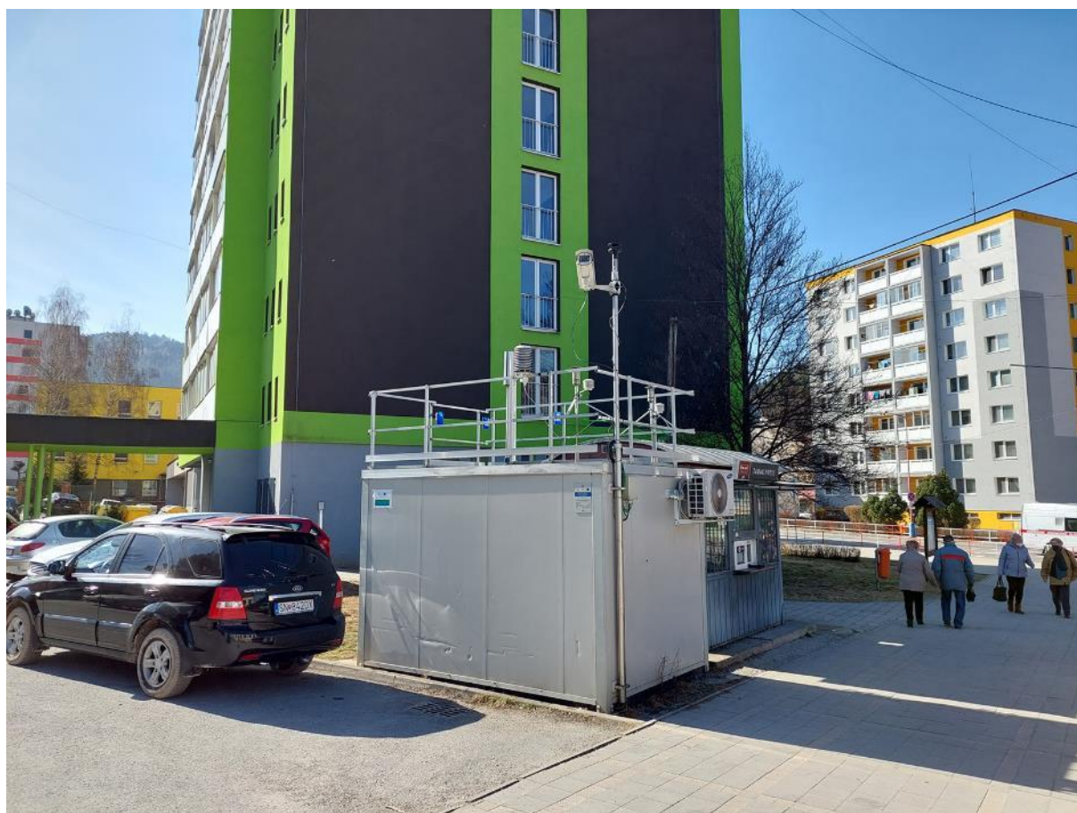
Pohľad na stanicu
