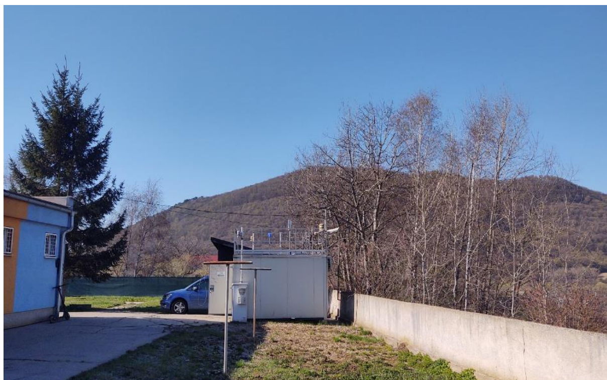
Pohľad na stanicu
