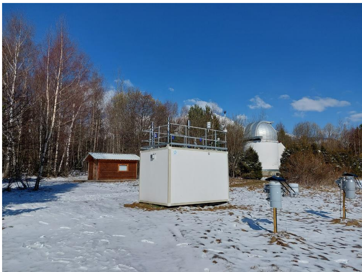
Pohľad na stanicu
