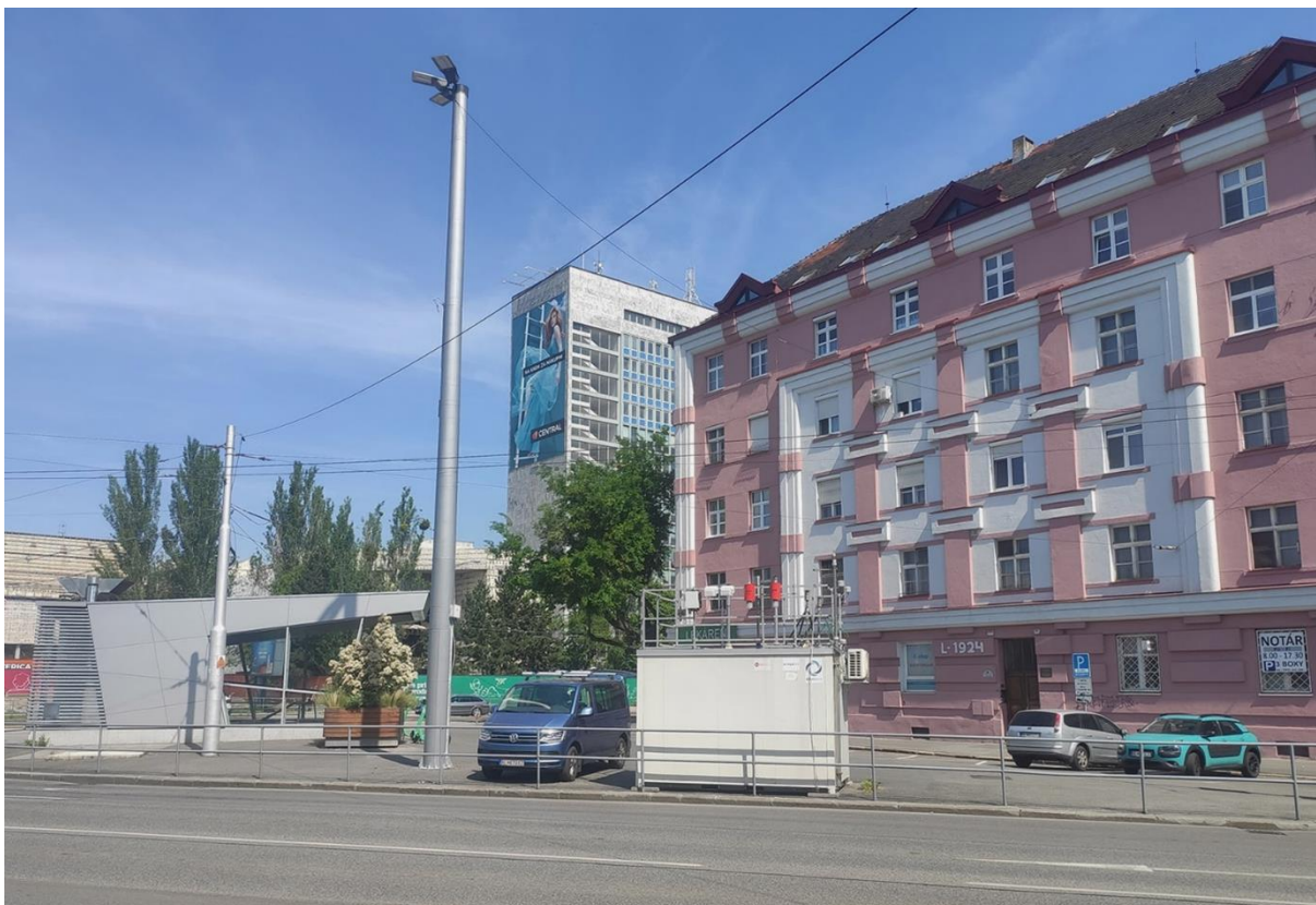
Pohľad na stanicu
