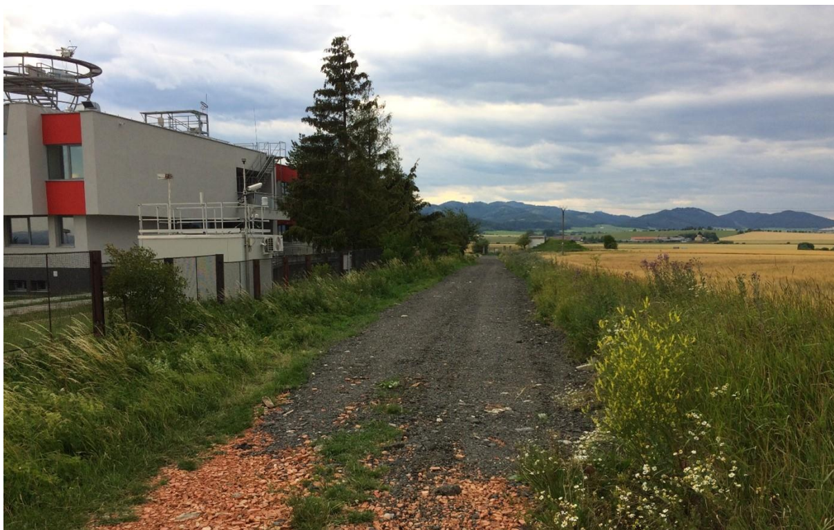
Pohľad na stanicu
