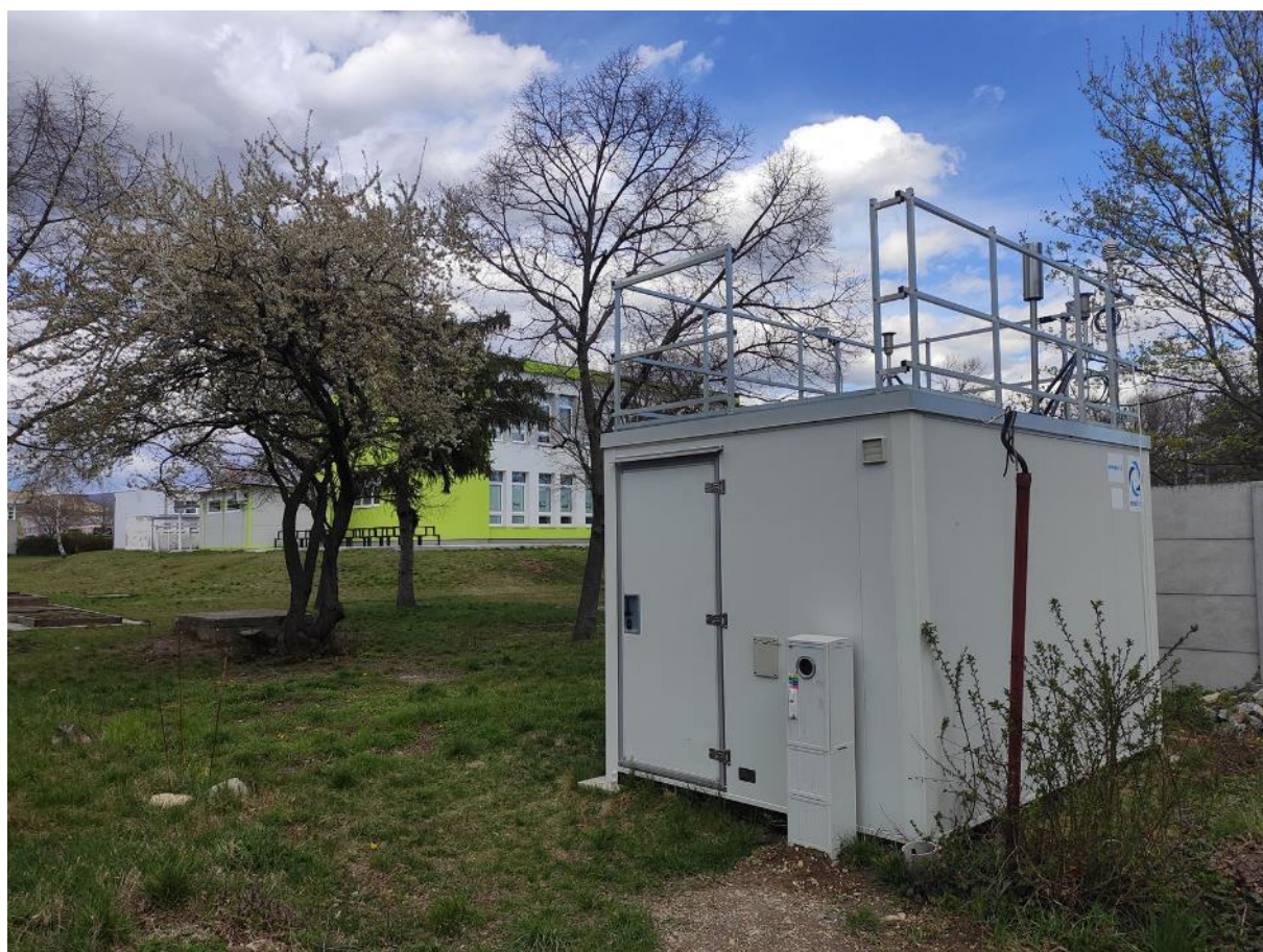
Pohľad na stanicu
