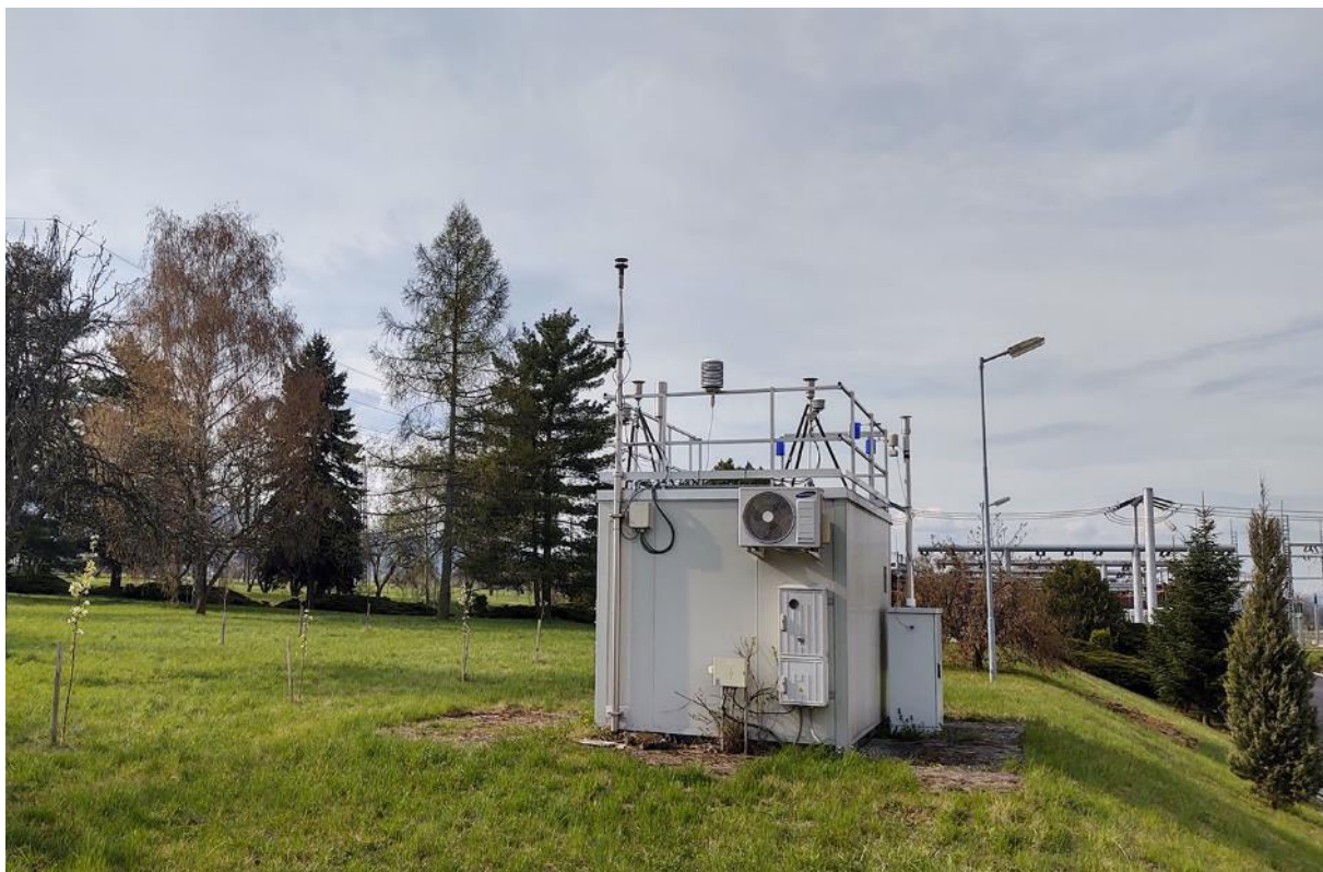
Pohľad na stanicu
