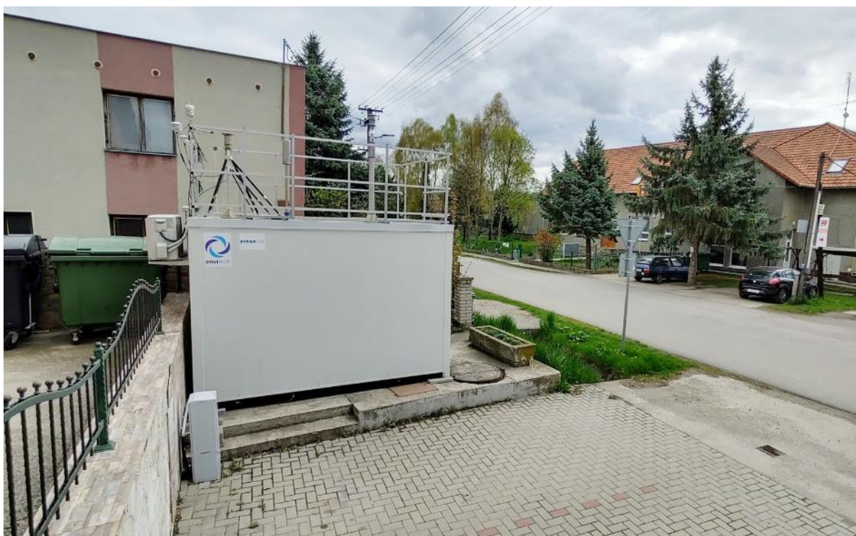
Pohľad na stanicu
