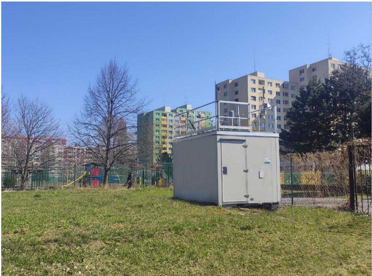
Pohľad na stanicu
