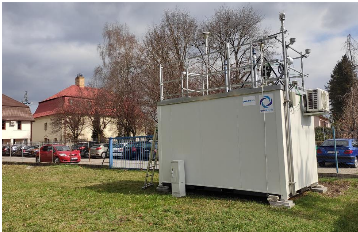
Pohľad na stanicu
