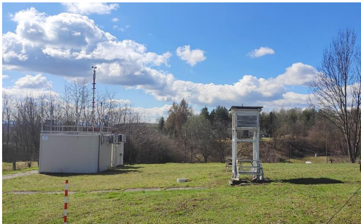
Pohľad na stanicu
