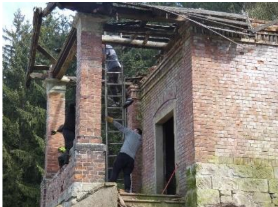
Obrázok 8 Záchrana kamennej tabule z rozpadnutého tympanónu
