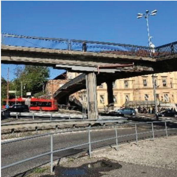
Fig. 9 Current state of the overpass (Zaťovičová, 2019)
