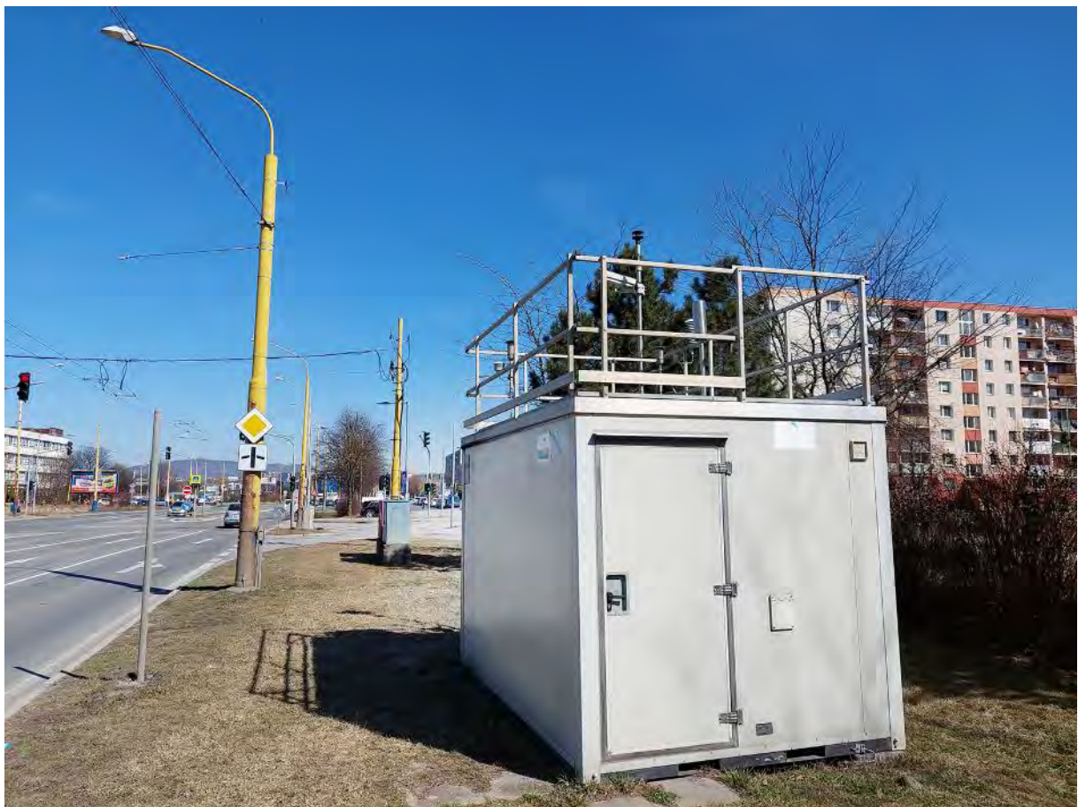
Pohľad na stanicu
