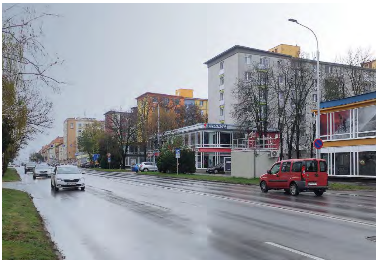
Pohľad na stanicu
