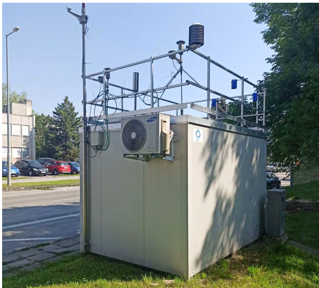
Pohľad na stanicu
