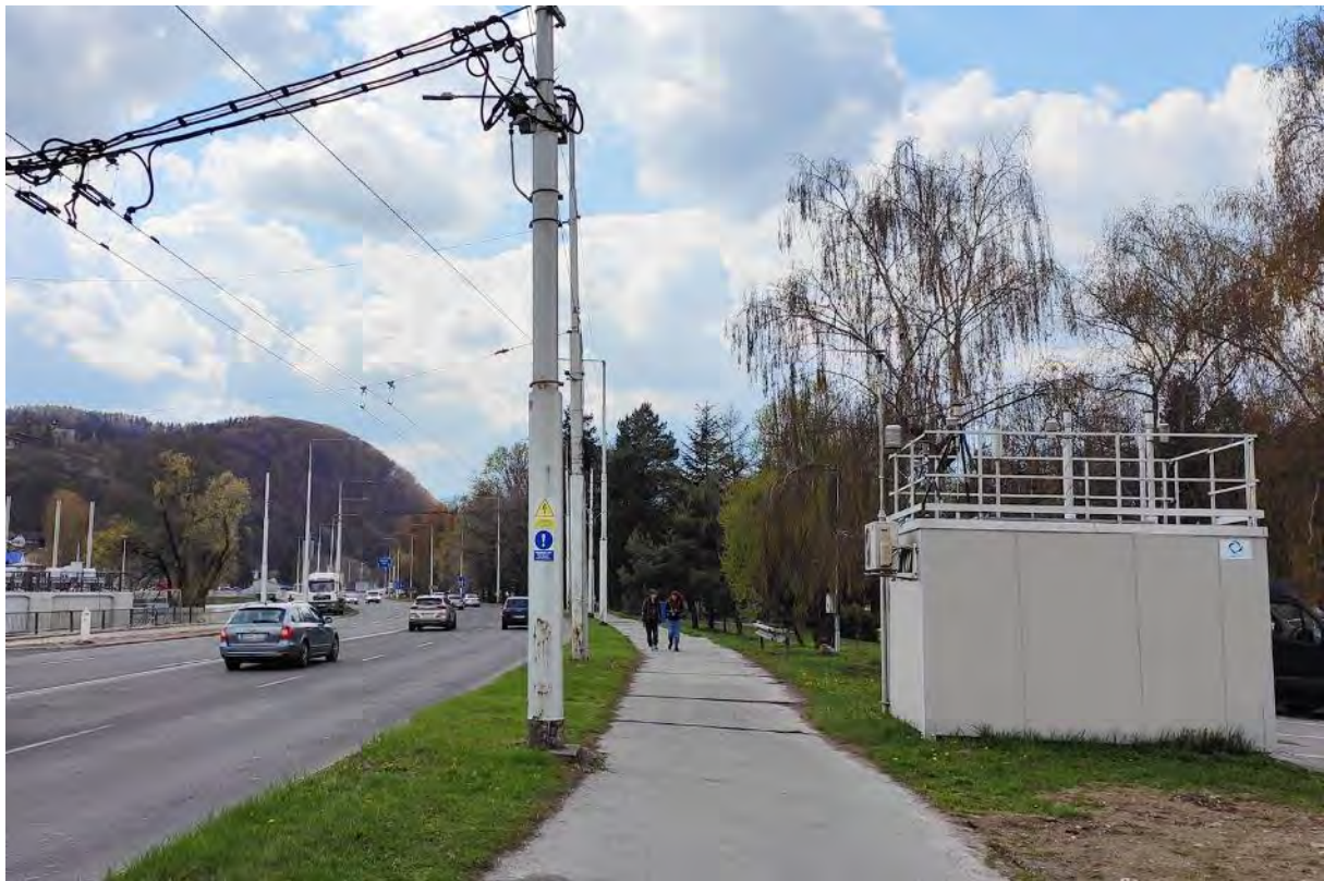
Pohľad na stanicu
