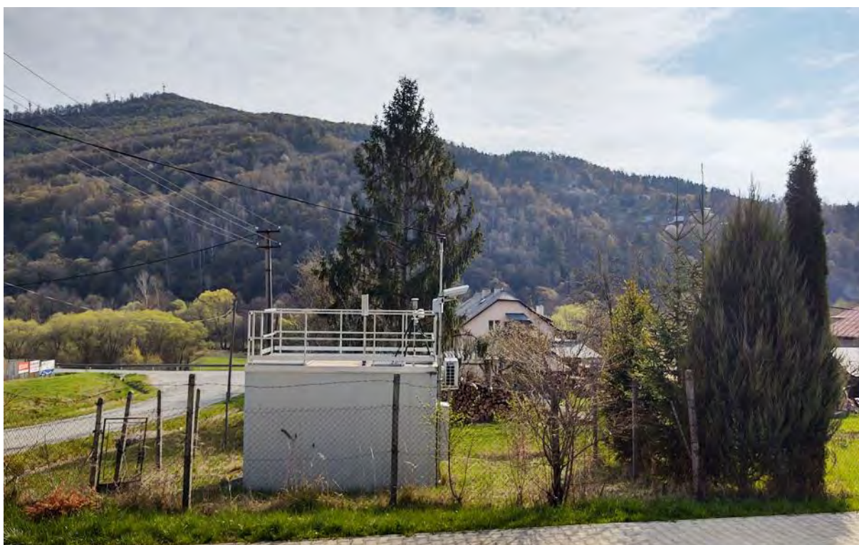
Pohľad na stanicu
