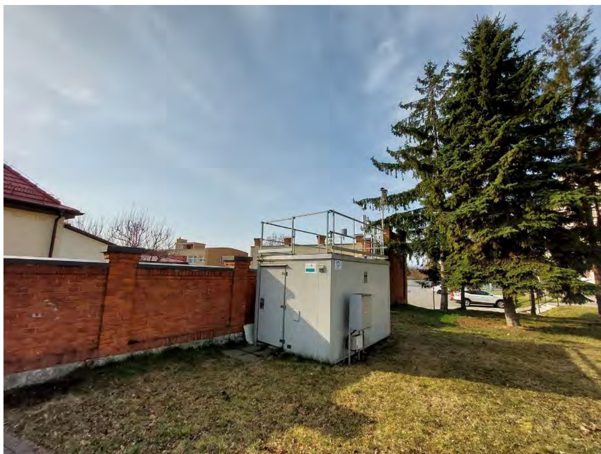
Pohľad na stanicu
