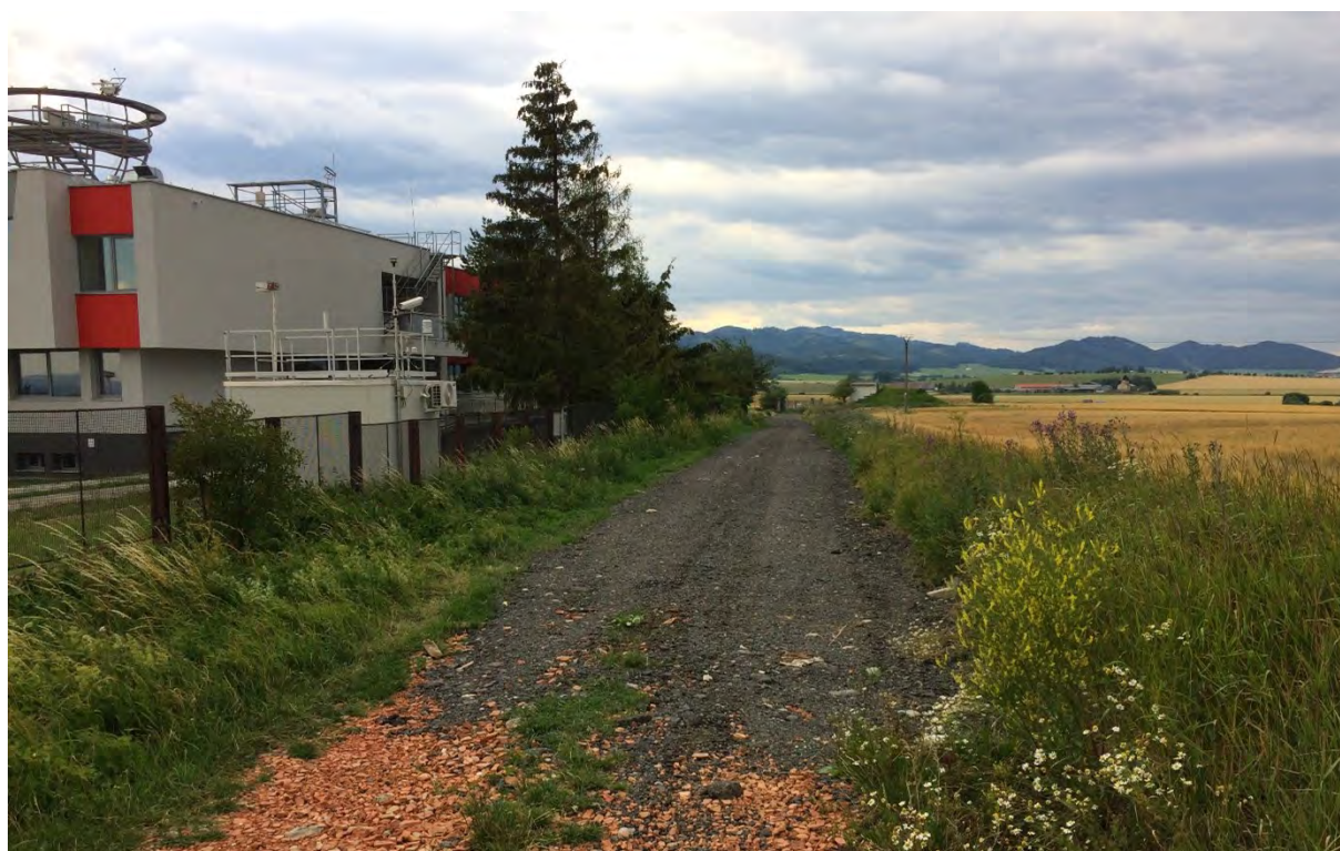
Pohľad na stanicu
