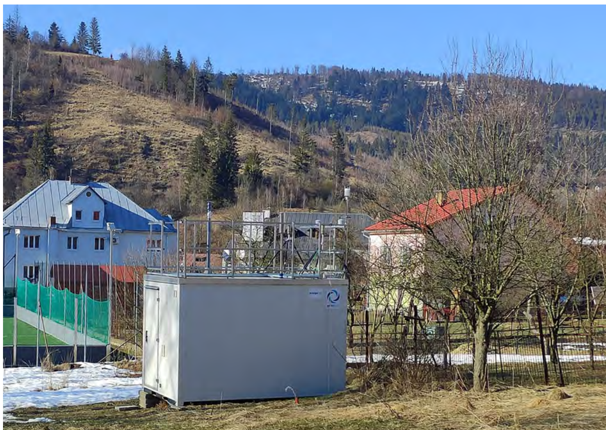
Pohľad na stanicu
