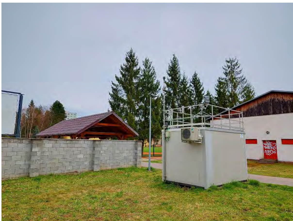
Pohľad na stanicu
