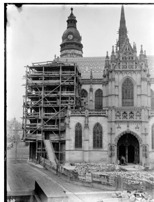
Obr. 10: Vonkajšie lešenie dómu počas obnovy vedenou Imre Steindlom Zdroj: https://memmdk.hu
