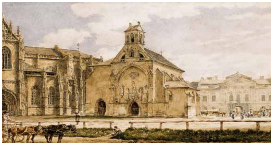
Obr. 12: Stav kaplnky pred obnovou
