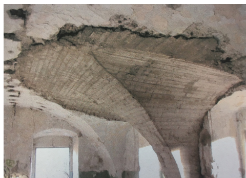
Obr. 12: Východné krídlo, dobetónovaná klenba. Zdroj: Archív KPÚ Žilina, pracovisko Ružomberok, 2001.
