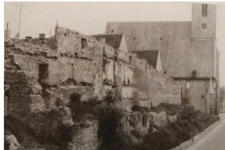
Obr. č. 6: Stav hradieb na západnej strane pred rekonštrukciou, 20. storočie (Zdroj: HANÁK, Jozef. Prešporské opevnenia . Bratislava: Marenčin PT, 2007, s. 160.)
