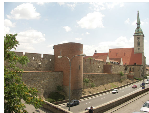
Obr. č. 7: Súčasný stav hradieb západnej časti (Zdroj: http://mapio.net/pic/p-2095846/ [20.6.2017])
