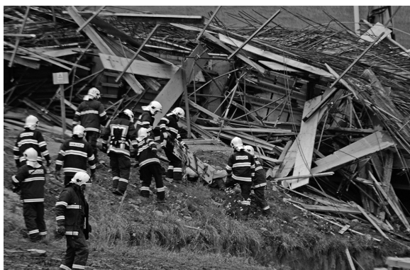
Pri obci Kurimany, okr. Levoča, sa 2. novembra 2012 okolo 14.30 h. zrútil diaľničný most vo výstavbe.
