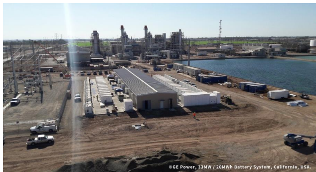
Obr. 12. Inštalácia BESS o výkone 33MW a kapacite 20MWh umiestnená v Kalifornii [43]
