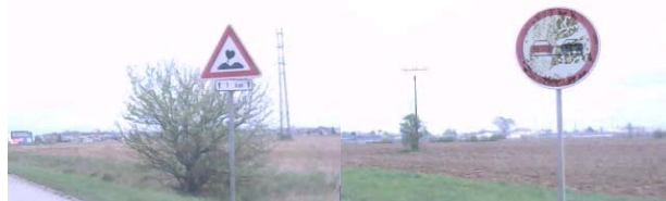
Obr. 16. Dopravné značky s poškodeným piktogramom
