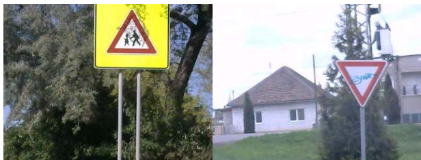
Obr. 15. Dopravné značky s narušenou farebnou homogenitou ich doplnkovej časti
