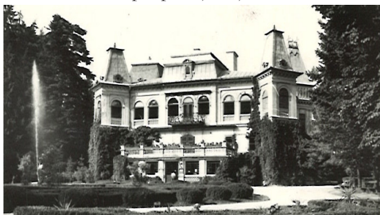
Obr. č. 1: Kaštieľ v Betliari. Zdroj: Archív SNM, pobočka Betliar
