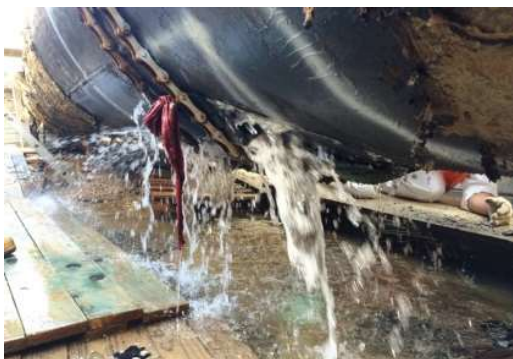
Obr. 1 Oprava potrubia za prevádzky
