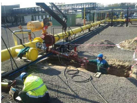
Obr. 4 Napojenie nového potrubia za prevádzky
