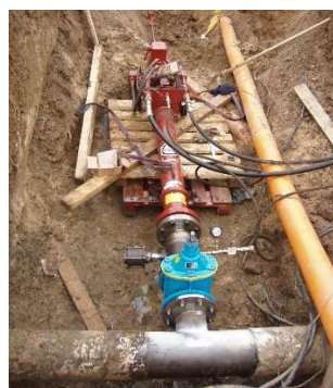
Obr. 4 Napojenie nového potrubia za prevádzky
