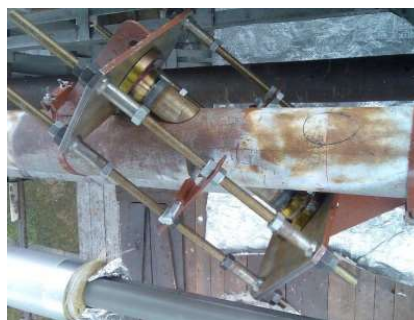
Obr. 5 Inštalácia nových ultrazvukových prietokomerov potrubia za prevádzky
