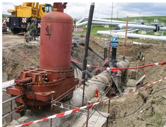
Obr. 3 Prekládka trasy potrubia za prevádzky
