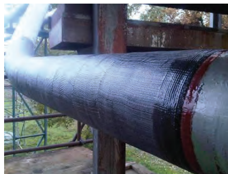
Obr. 14 Aplikácia uhlíkovej bandáže
