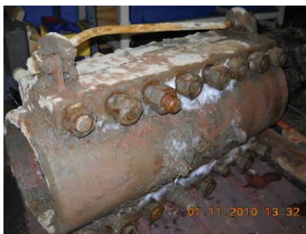
Obr. 24 Delená ocelová objímka po demontáži z potrubia
