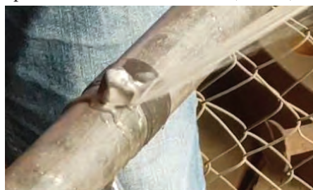
Obr. 16 Aplikácia tesniacej pásky s výplňovým tmelom na priamom úniku
