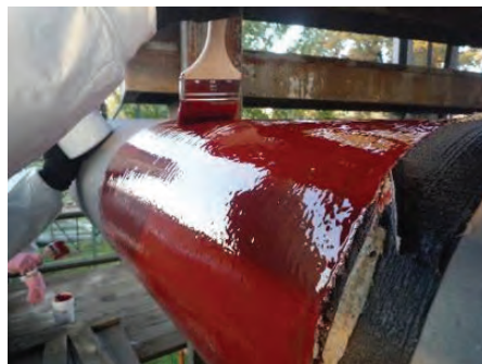
Obr. 13 Aplikácia epoxidového základného náteru
