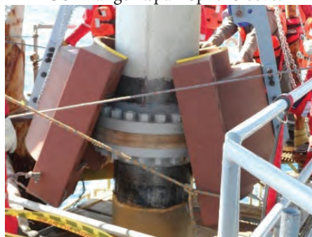
Obr. 21 Inštalácia prírubovej tesniacej objímky
