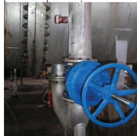
Obr. 22 Nový uzáver vymenený „za prevádzky“
