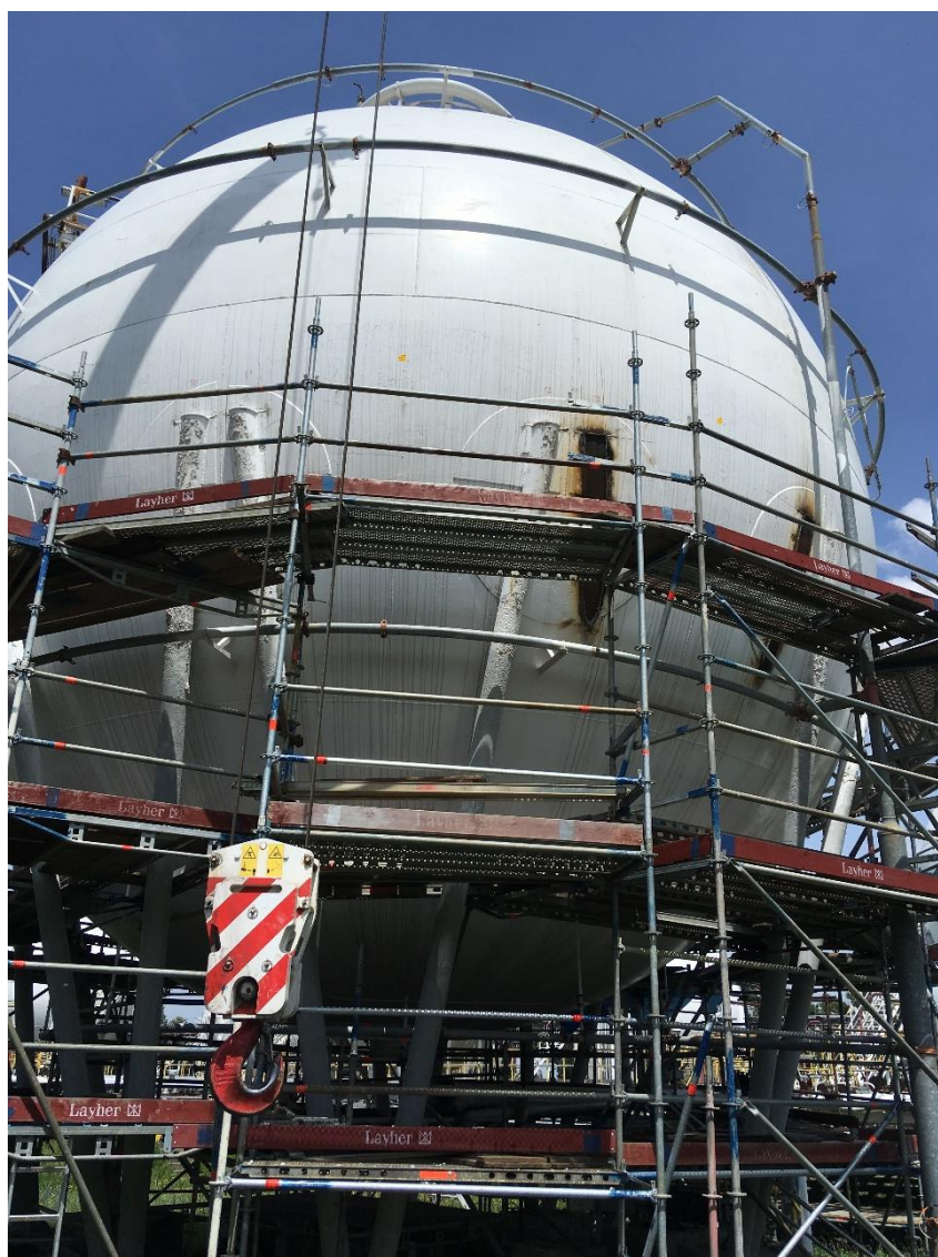
Obr. 10 Výmena nôh guľového zásobníka (nádrž č. 3)
