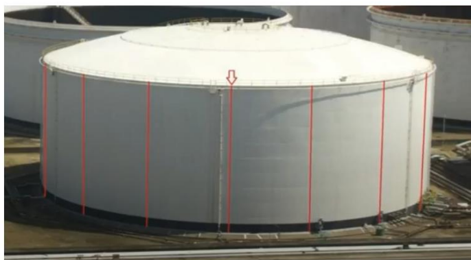
Obr. 4 Meracie profily vertikality (tolerancie API 653)
