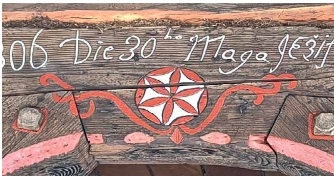
Dom z Oščadnice č. 795 – portál vstupu po zásahu (Zdroj: Fotoarchív Kysuckého múzea)
