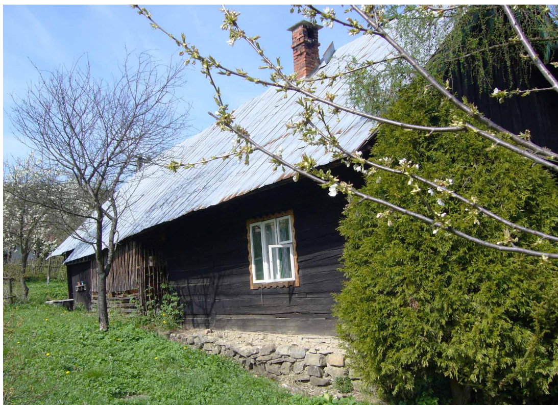
Dom v Zákopčích U Holých (Foto: A. Kontrík)
