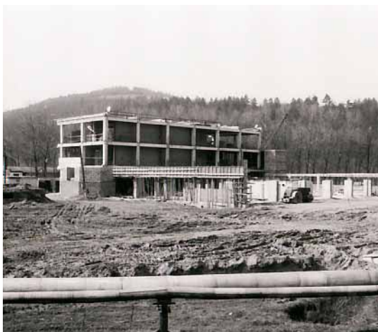
Výstavba plavárne v Čadci, 15. 4. 1984 (Zdroj: foto M. Golis)
