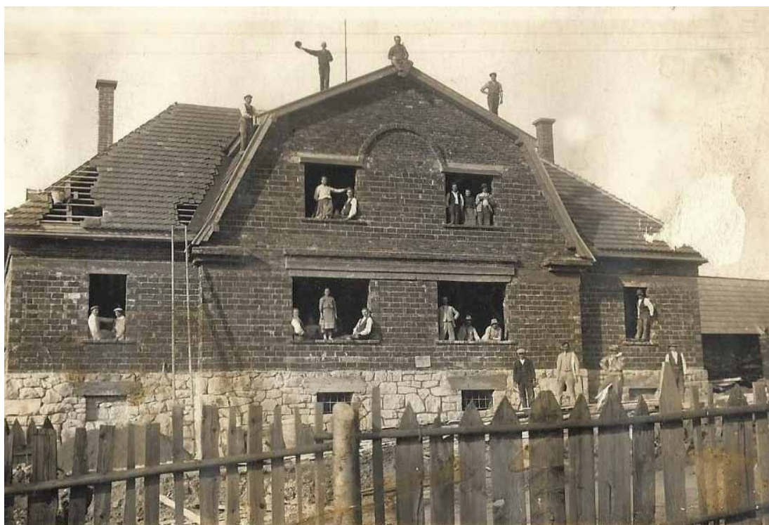
Výhrevňa depa v Zákamennom pred dokončením (Zdroj: FB Zákamenné na historických fotografiách)
