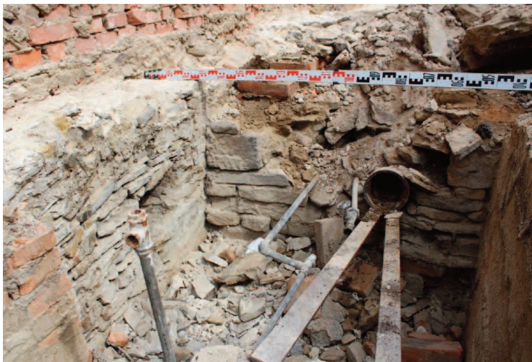
Suterén asanovaného domu na Belanského ulici (Foto: M. Kvietok)
