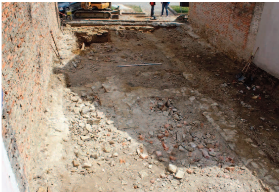
Základy asanovaného domu na Belanského ulici (Foto: M. Kvietok)
