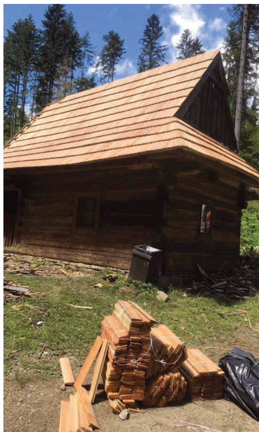
Výmena šindľa na streche domu lesných robotníkov v MKD vo Vychylovke (Foto: Kysucké múzeum)
