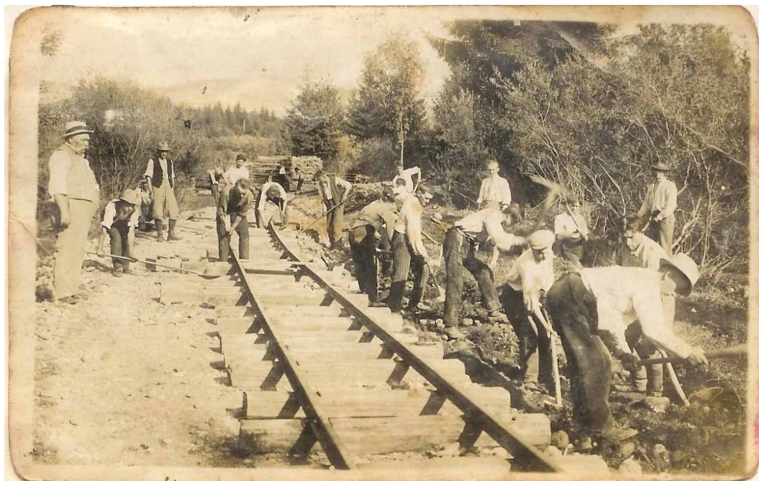
Budovanie lesnej železnice medzi Oščadnicou a Chmúrou (Zdroj : Ivan Žilinčík: Klapot kolies v údoliach Bystrice a Bielej Oravy, 2006)
