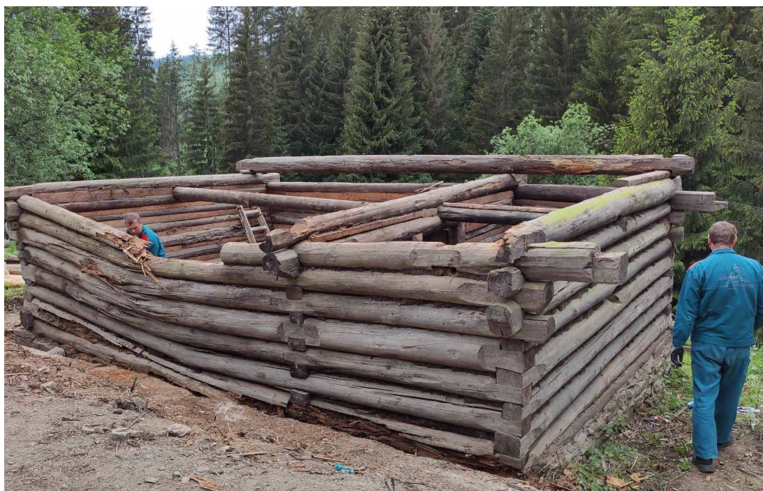
Demontáž stavby a odstraňovanie zhnitých drevených komponentov. (Foto: Marián Liščák)
