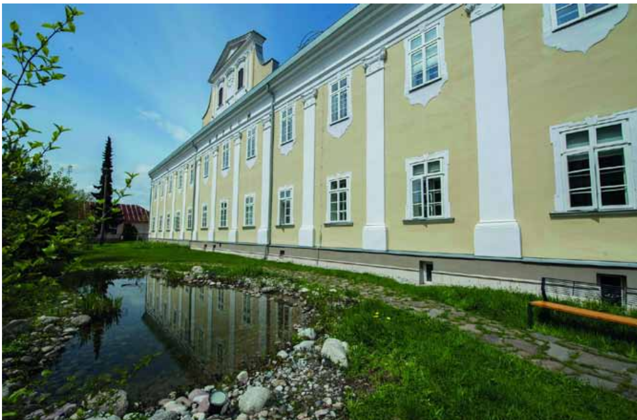
Obr. 6. Exteriér budovy múzea v Liptovskom Mikuláši po rekonštrukcii (2016). Zdroj: Archív ochrany prírody a jaskyniarstva Liptovský Mikuláš, foto: Michal Oravec
