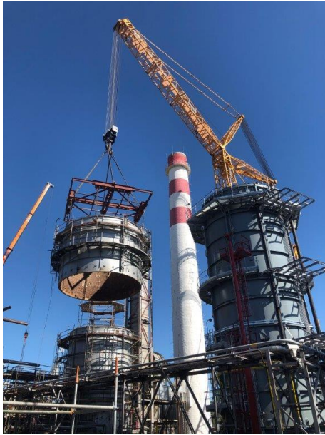
Obr.7 Demontáž ¼ radiačnej časti pece.
