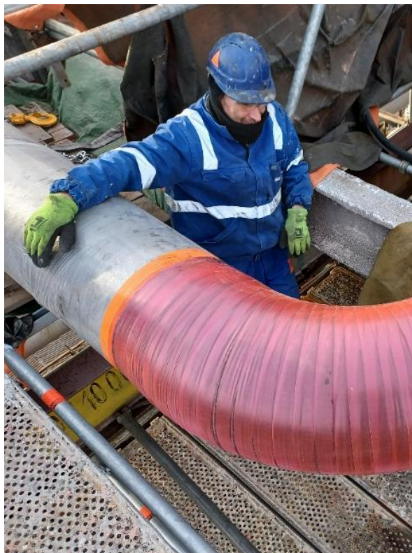
Obr. 9. Finálna podoba systému Belzona SuperWrap II
