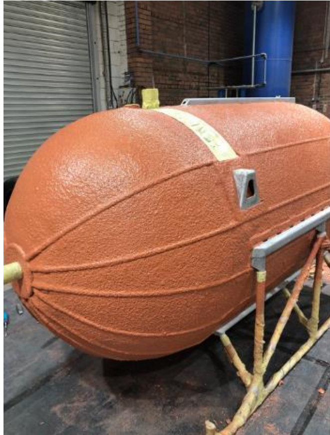
Obr. 2 Aplikácia produktu Belzona 5871 na komplikovanú plochu
