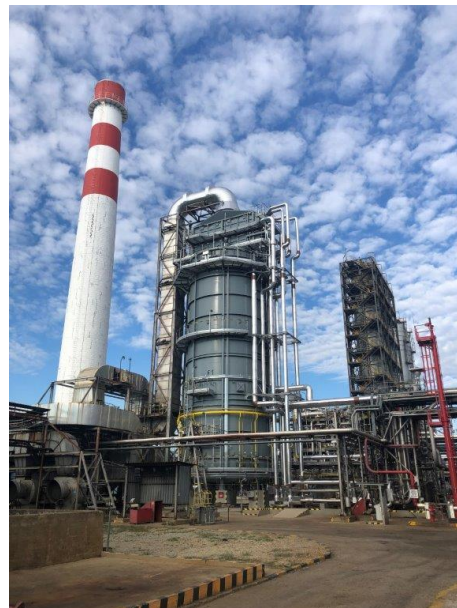
Obr.13 Nová destilačná pec F1 spustená do prevádzky 06/2022
