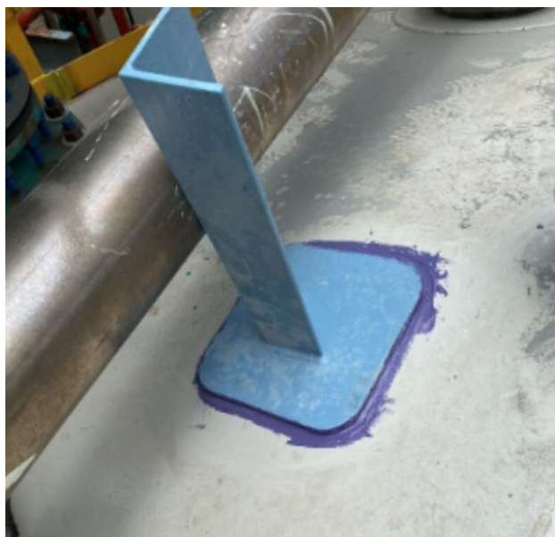
Obr. 6 Prilepenie konzoly bez tepelného ovplyvnenie steny nádrže
