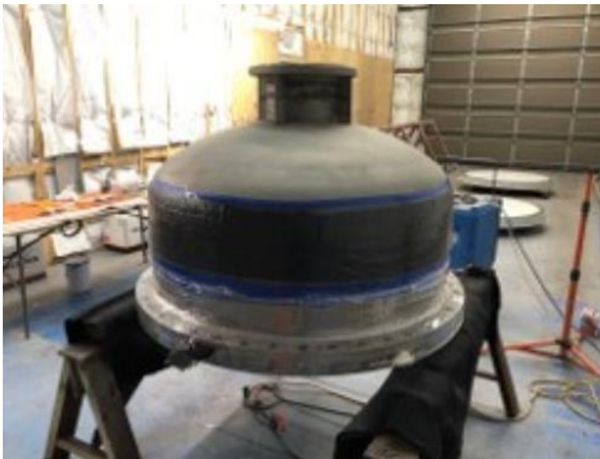
Obr. 11 Systém Belzona SW II aplikovaný z oboch strán veka
