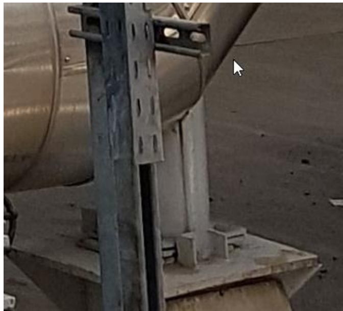
Obr. 9: Detailný pohľad na ukotvenie potrubia [1]
