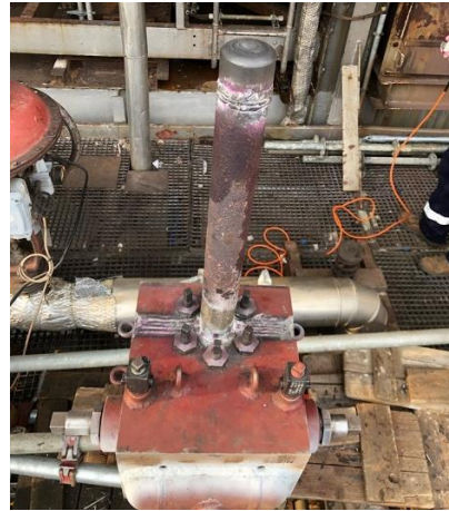
Obr.17 Odrezané jestvujúce potrubie a navarené klenuté dienko
