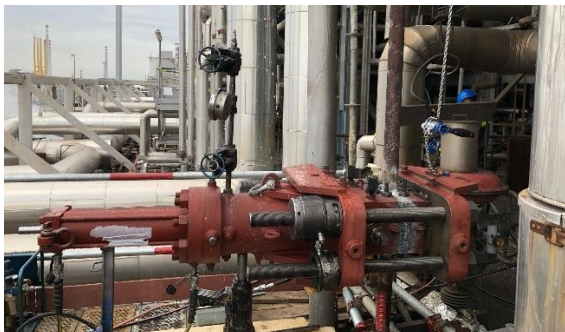
Obr.14 Uzatvorenie potrubia za prevádzky
