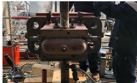
Obr.15 Navarenie privarovacieho dna
