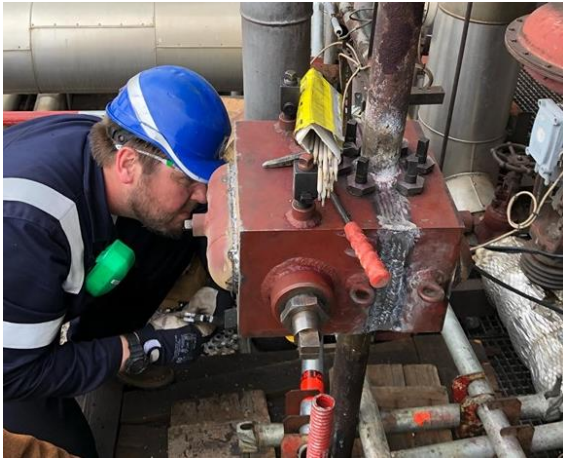
Obr.16 Demontáž zariadenia, na potrubí zostáva uzatvárací blok
