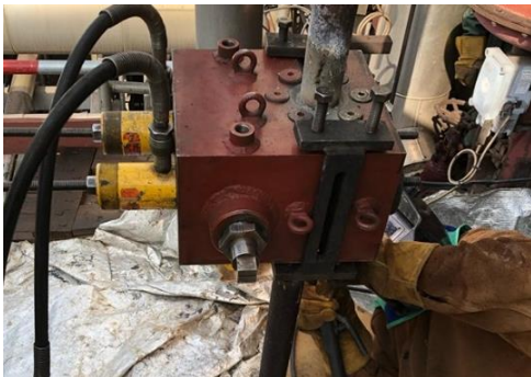
Obr.12 Navarenie uzatváracieho bloku
