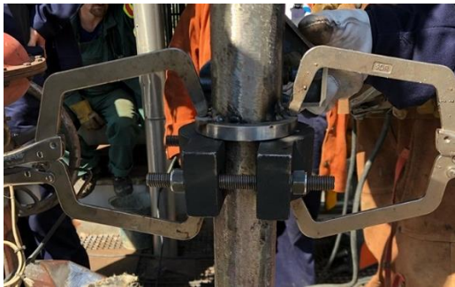
Obr.10 Navarenie výstužných prstencov
