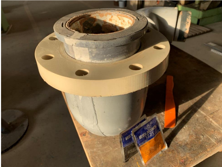
Obr. č. 7 PVC potrubie po oprave
