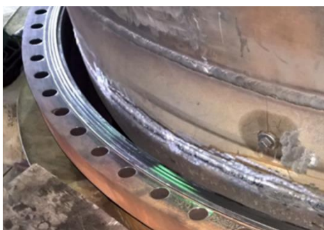
Tesnenie DynaGraph na pozícii
