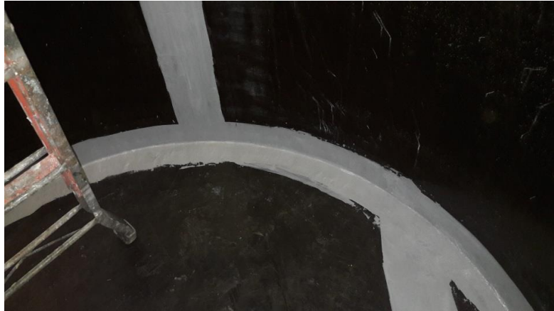
Obr. č. 5 Oprava zvarov PP nádrže
