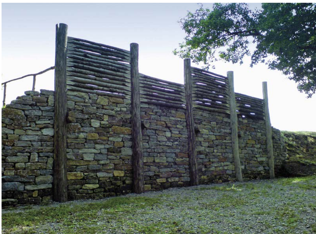
Rekonštrukcia časti valu keltského oppida , Burgstal pri Finsterlohr, Nemecko 50
