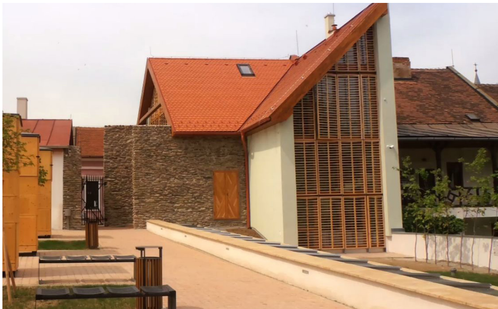
Dom remesiel krátko po dokončení
