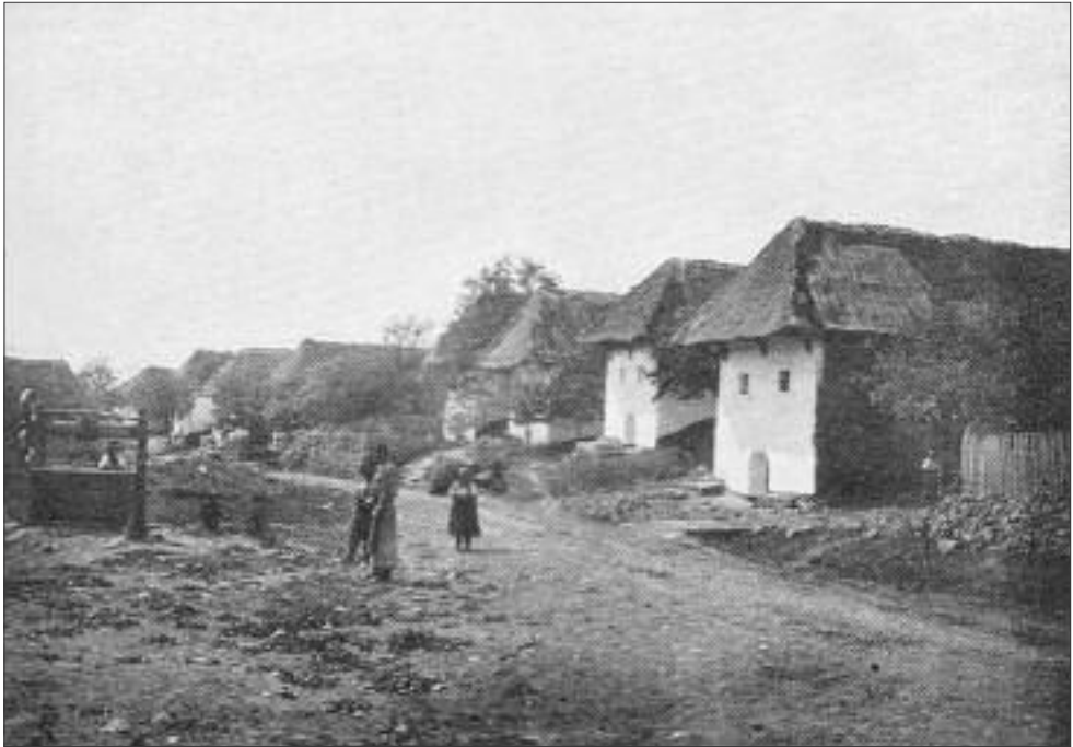
Obr. 03: Cerovo 1905 řadová náves s těsným sousedstvím usedlostí s valbovou doškovou střechou. Foto: K. Chotek, pozůstalost Karla Chotka, soukromé vlastnictví rodiny Chotkovy
