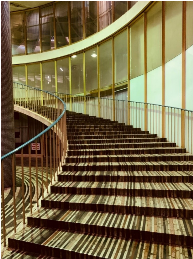
Fig. 8.4. Stair detail. (Photo: Cornelius van der Westhuizen, 2022)
