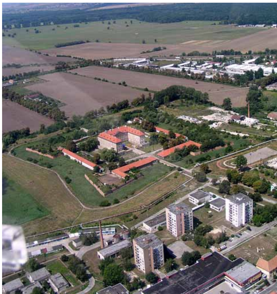
Obr. 6. Národná kultúrna pamiatka Holičský kaštieľ s areálom v 90. rokoch 20. storočia – západný pohľad na areál kaštieľa s bytovkami a teplovodom na mieste parku vo východnom predpolí opevnenia. Zdroj: Archív oddelenia OVaŽP Mestského úradu v Holiči
