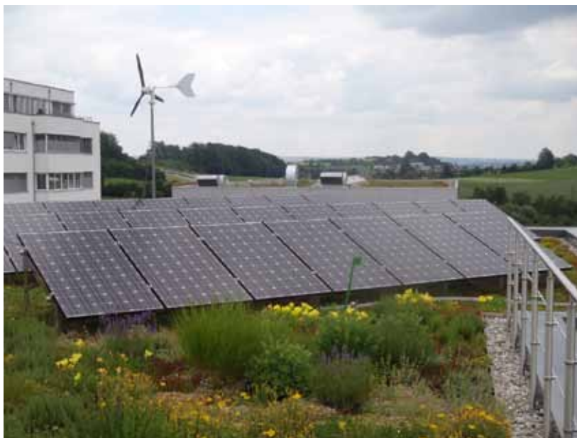
Obr. 1. Moderná zelená strecha kombinovaná s fotovoltaikou (Stuttgart, Nemecko, 2016). Foto: Ľuboš Jurík
